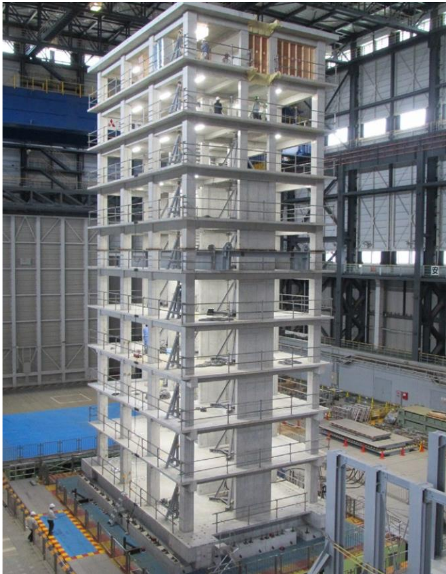
شکل ۱۵ ساختمان ۱۰ طبقه بتن‌آرمه تست شده در E-Defense ژاپن (۲۰۱۵)
