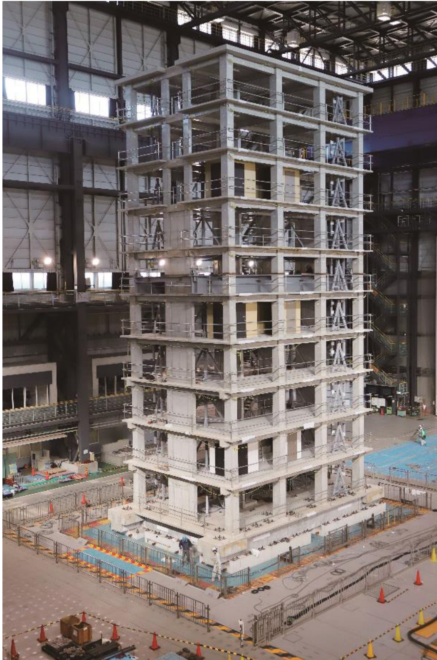
شکل ۱ ساختمان ۱۰ طبقه بتن‌آرمه تست شده در E-Defense ژاپن (۲۰۱۵)
