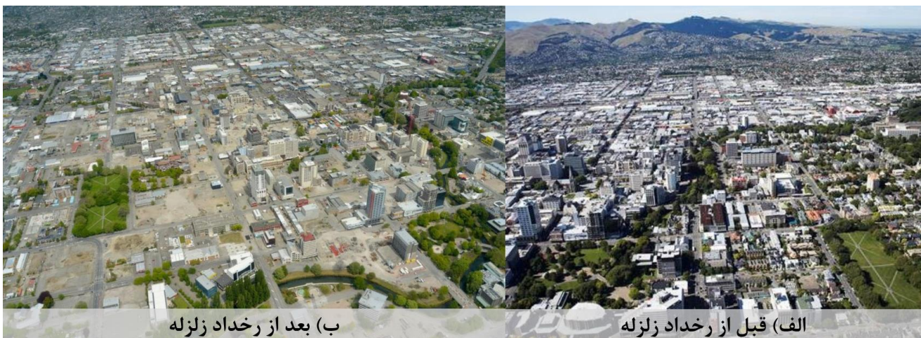
شکل ۱ تاثیر زلزله کنتربری ۲۰۱۱ بر مرکز تجاری کرایسچرچ
